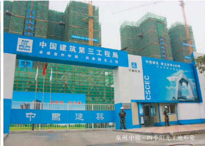
项目工地安全检查
